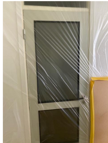
Bild 3: Inplastning av väggar
